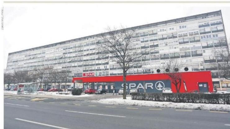
Glavni usjet za prijavu na natječaj Fonda bio je potpis 51 posto stanara zgrade. Budući da ih u toj velikoj zgradi ima oko 500, predstavnicima zgrade to nije bilo lak zadatak.
